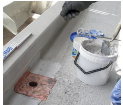
Kleben eines Kupfer-Abflufs
