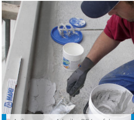
Auftragen von Adesilex PG4 auf den Untergrund
