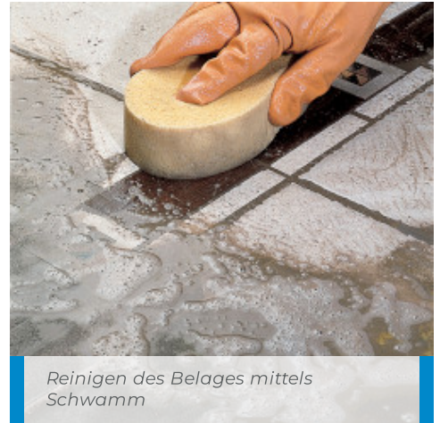
Reinigung mittels Schwamm
