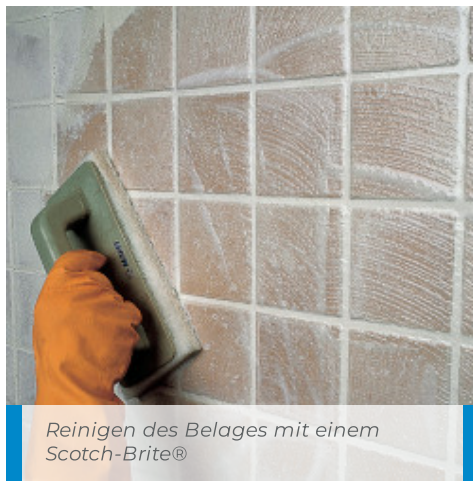
Reinigung mittels Schwamm
