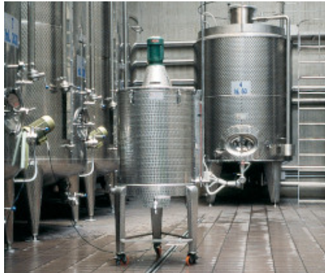
Säurefeste Verfügung in einer Weinkellerei
