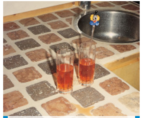
Klebung und Verfügung einer Arbeitsplatte mit Kerapoxy
