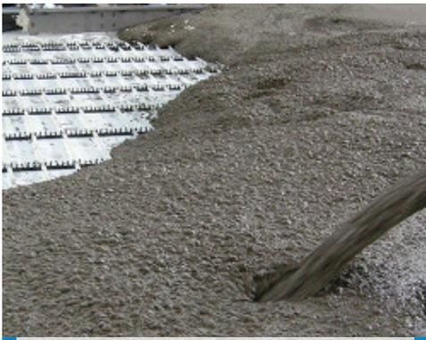
Einbau von Beton mit Mapefibre NS12 zur Verringerung der Rissbildung infolge plastischen Schwindens
