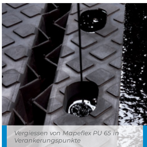
Übergang abgedichtet mit Mapeflex PU 65, gemischt mit Sand
