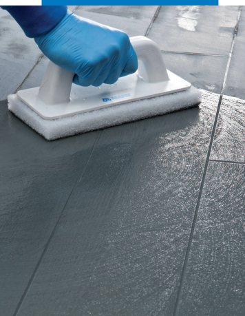
Waschen des angezogenen Fugenmörtels mit einem Schwambrett (z.B. Scotch-Brite)
