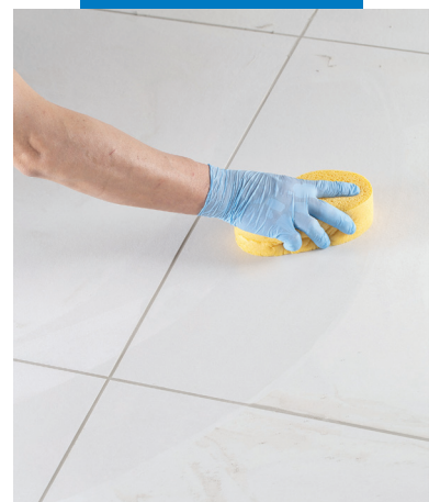
Endreinigung des Fugenmörtels mit einem Schwamm
